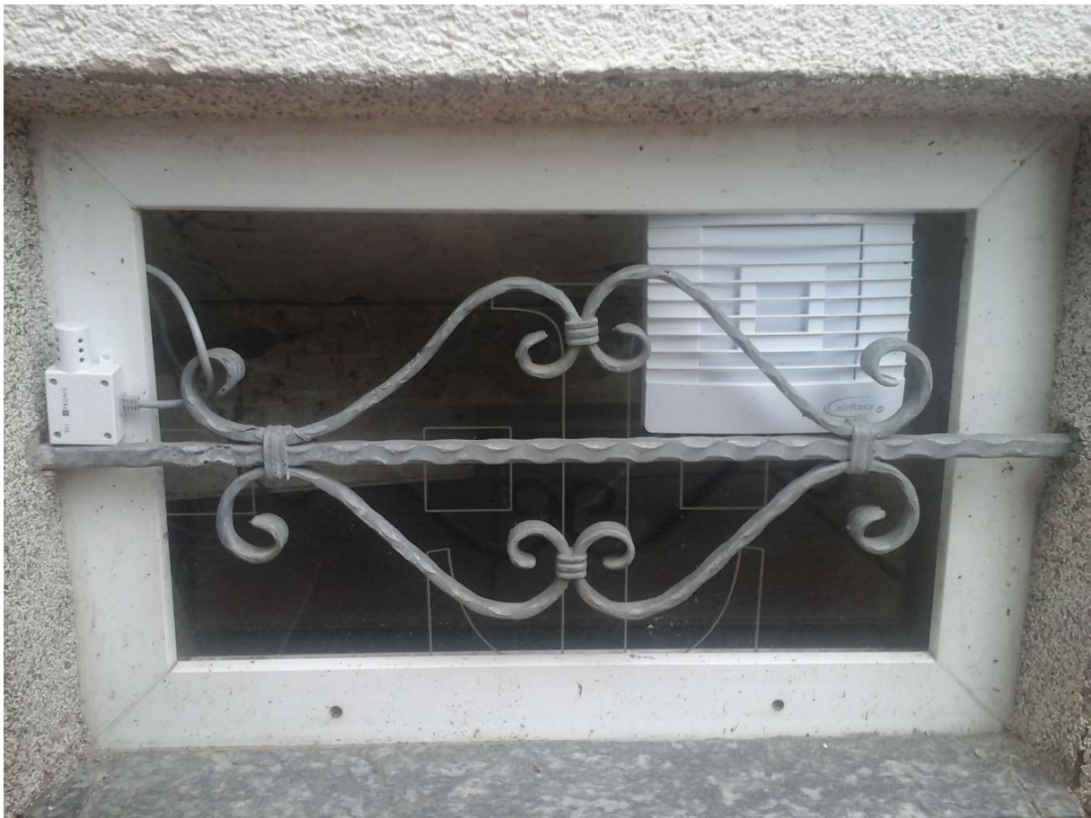
Beispiel: Lüfter mit Rückschlagklappe in einer Kellerfensterscheibe aus Plexiglas und rechts der Außensensor Nr. 2.
