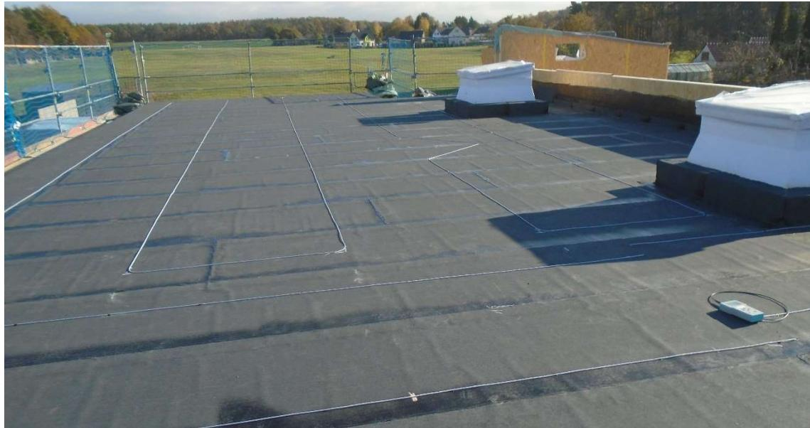
Verlegung des Feuchte-Sensorkabel „D“ bis zu 100 m, pro Abschnitt auf dem Flachdach.
