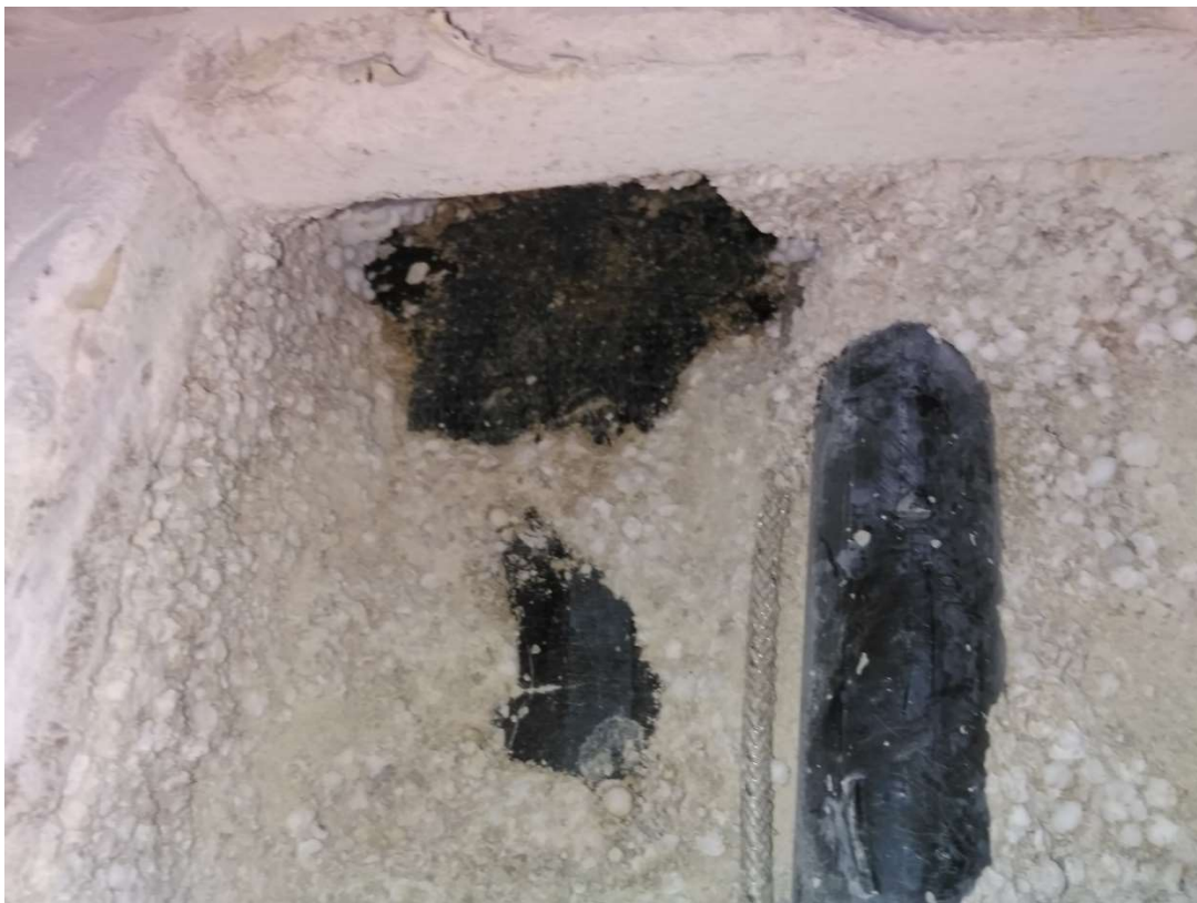
Abbildung 12 freigelegter Bereich unter der Duschtasse, Feuchtigkeit ist mess- und fühlbar vorhanden. Die Feuchtigkeit setzt sich in Richtung der Duschtasse fort
