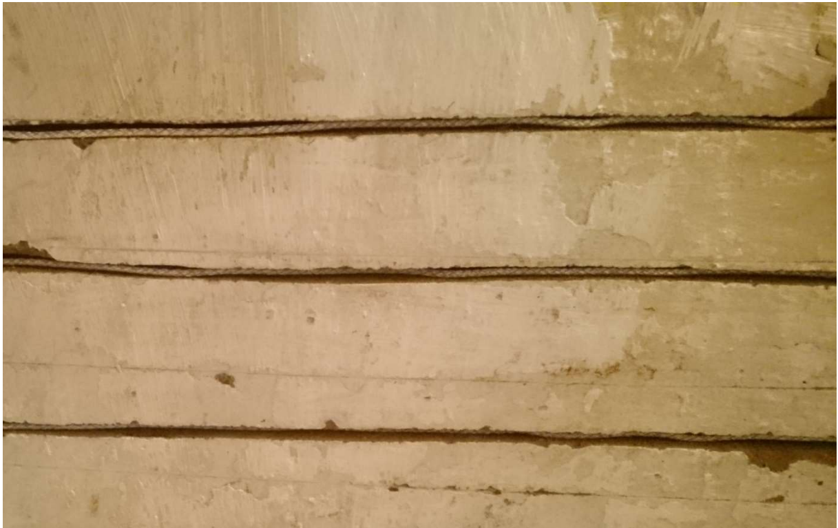
Verlegung der Wandheizung im Mauerschlitze
