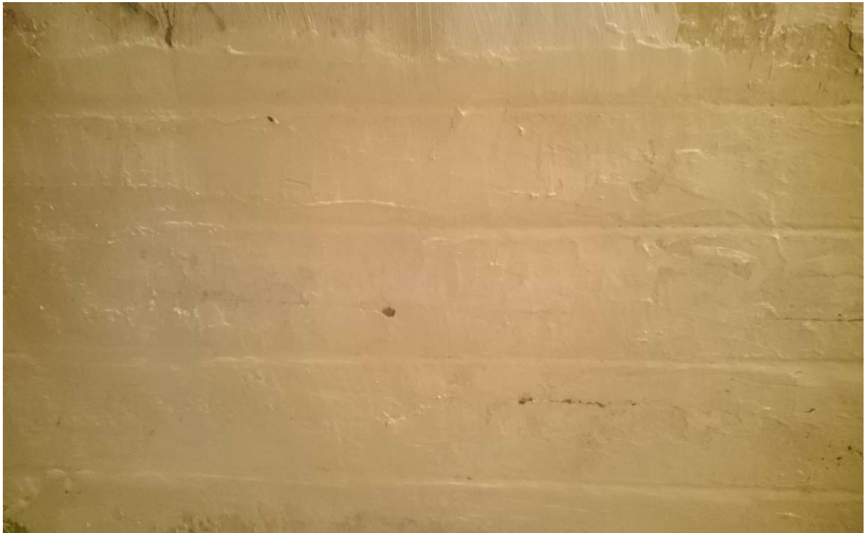
Verspachtelte Mauerschlitze mit innenliegender Wandheizung
